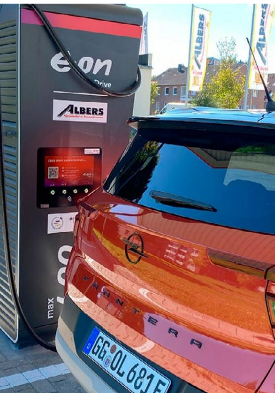
Schnellladen unterm Solardach: Auf dem Parkplatz von Möbel Albers in Papenburg bietet E.ON Drive Infrastructure zwölf Ladepunkte mit bis zu 400 kW Leistung – barrierefrei, mit Extras für Transporter und digitaler Preisanzeige direkt am Dach. Bezahlt wird unkompliziert per Karte an der Säule.
